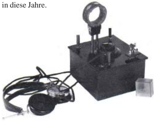
Erster Detektorempfänger mit Drehkondensator-Abstimmung
